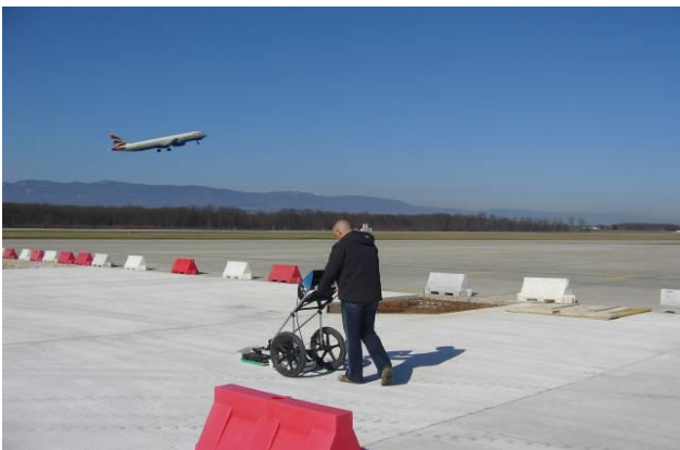
Cartographie des armatures sur le tarmac de l'aéroport de Genève-Cointrin
