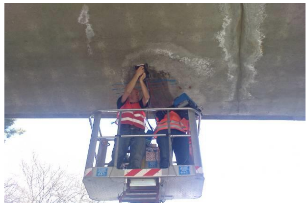
Auscultation non destructive d'un pont ; localisation des armatures et de la précontrainte
